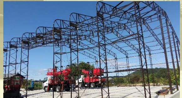
柱を立てたのち天井部分の骨組みを、組み上げます。地組した天井部をクレーンで吊り上げ、設置していきます。
